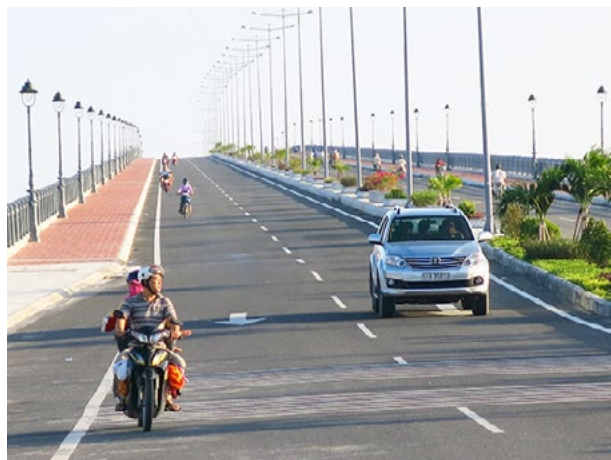
Hoàn thiện cơ sở hạ tầng là điều kiện cần thiết để công tác cải thiện môi trường đầu tư đạt hiệu quả. TRONG ẢNH: Cầu Cửa Đại trên cung đường ven biển Quảng Nam. Ảnh: N.P
